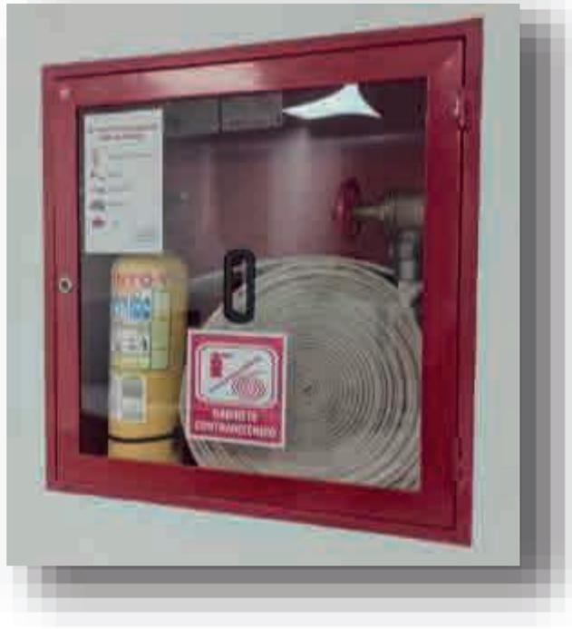
El sistema contra incendio construido en Salud y Servicios, está compuesto por 110 gabinetes los cuales están en cada piso tienen una válvula mariposa para corte y válvulas de drenaje independientes.
